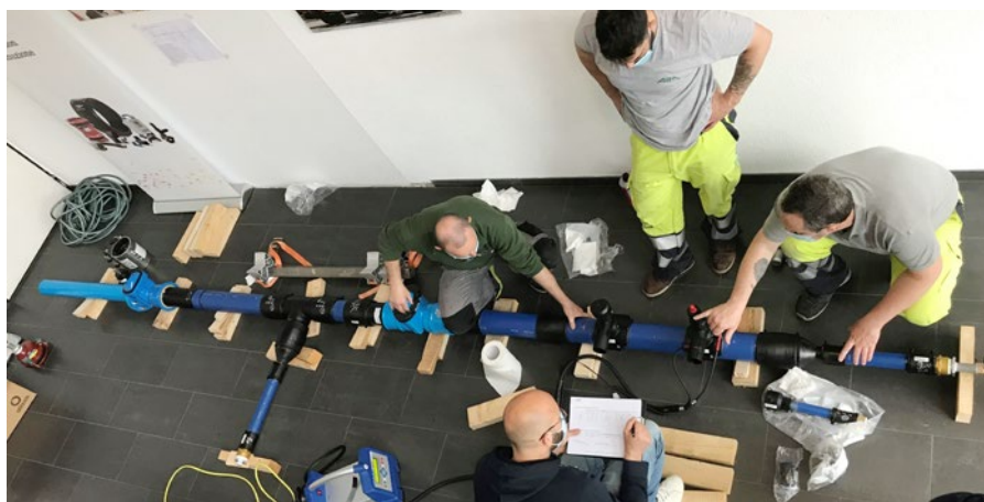
Praktisches Arbeiten – Rohrgraben.
