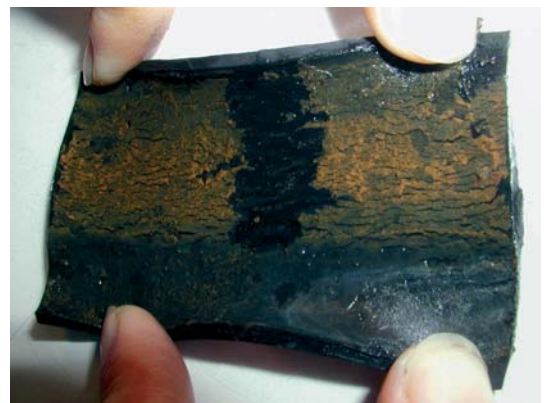
Abb. 10 Innenfläche des Gummis in einem Panzerschlauch einer Hausinstallation. (U. Szewzyk, Berlin)
