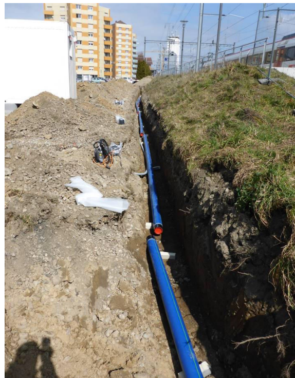
Diffusionsdichtes Schutzmantelrohr bereit im Graben zur Verarbeitung
