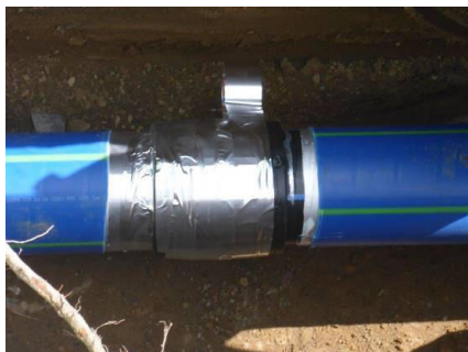
Umwickelte Schweissverbindung mit Alu-Band
