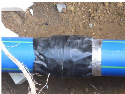
Geschützt mit Dichtungsband
