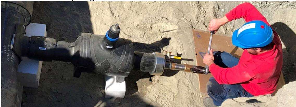
Es wird mit entsprechender Längenzugabe angebohrt, sodass der Rohrbutzen vollständig durchtrennt wird, aber die Gegenseite des Rohrs noch nicht beschädigt wird.
