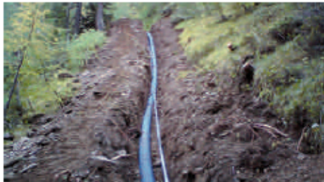
Offene Rohrverlegung mit Wiederverwendung Aushubmaterial
