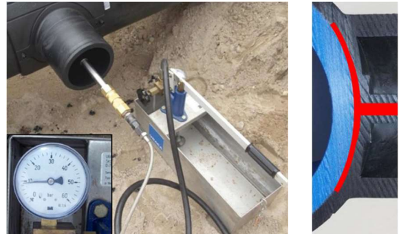
Druckprüfung vor dem Anbohren über den Abgang
