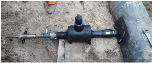
Grossrohrsattel – Anbohrung unter Betriebsdruck
