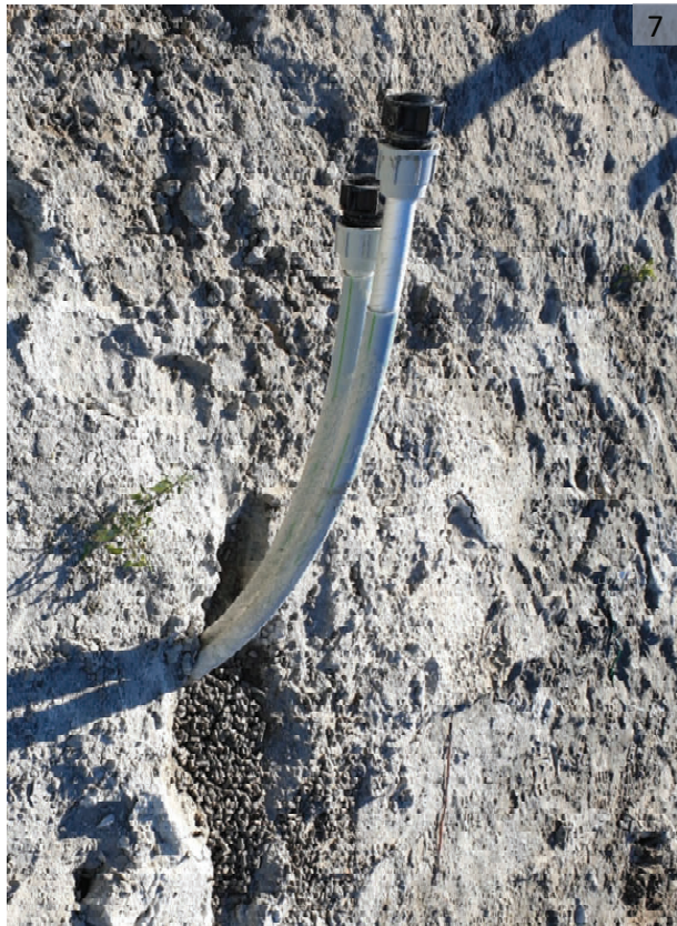
Bild 7: Bereits abgeteufte GEROtherm® REX Erdwärmesonden
