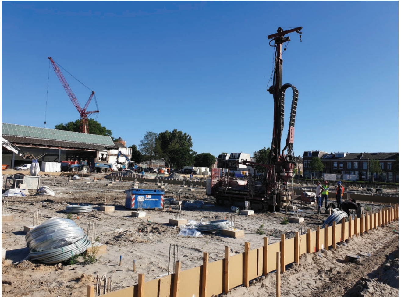
Baustelle: Wisselspoor Utrecht, NL Quelle: HakaGerodur
