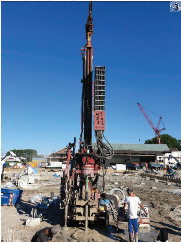
Bild 3: Bohrteam im Einsatz
