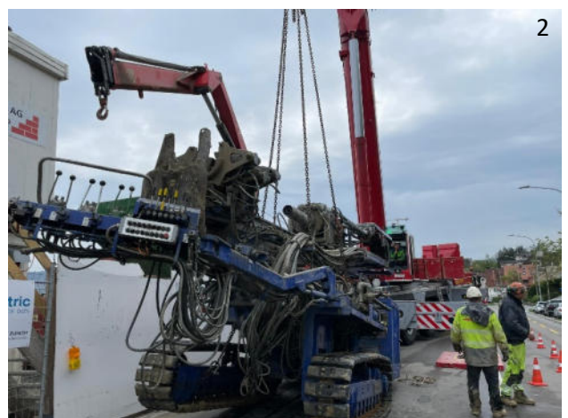
Bild 2: Vorbereitungsarbeiten auf der Baustelle
