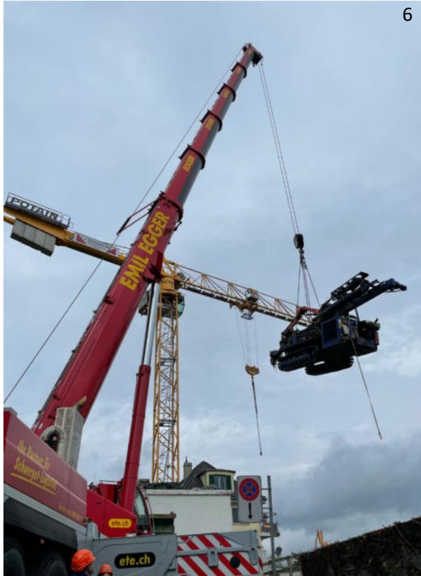
Bild 7: Das Bohrgerät wird mit dem Kran an die richtige Stelle gehoben
