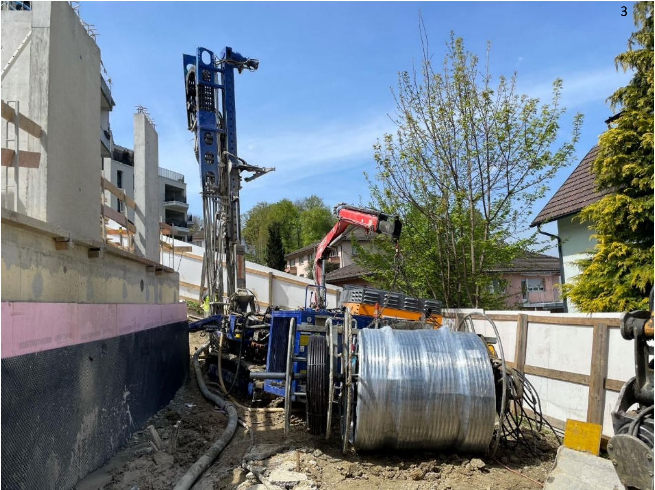
Bild 3: Erdwärmesonde bereit für den generationenübergreifenden Einsatz
