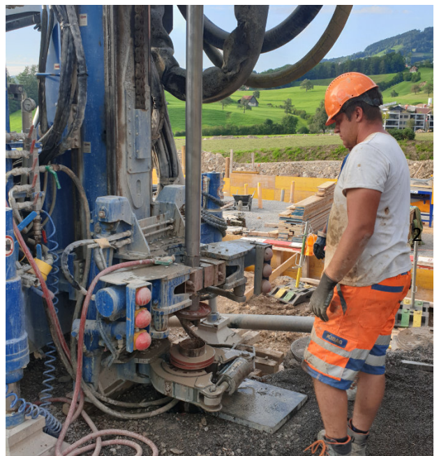
Bild 2: Ausbau der Bohrgestänge inkl. Bohrmeissel
