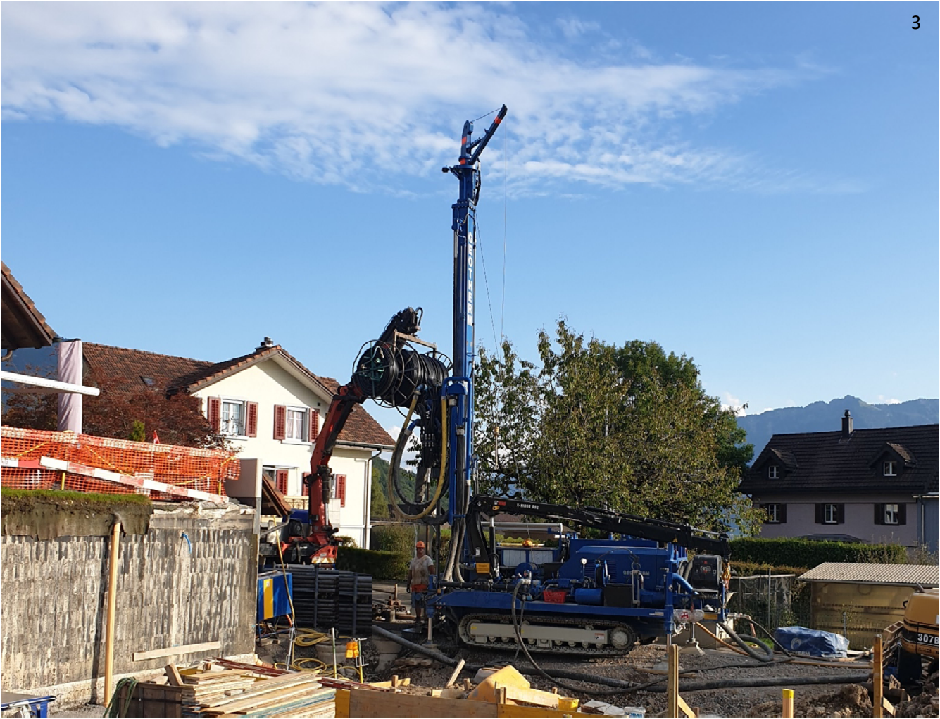
Bild 3: Erdwärmesonde bereit für den generationenübergreifenden Einsatz
