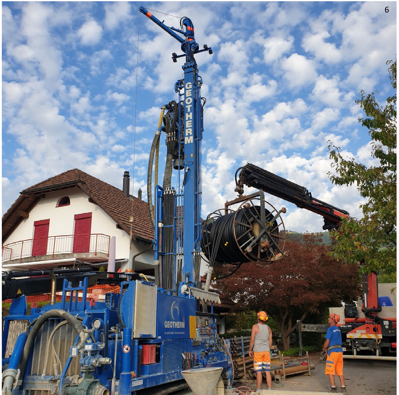
Bild 6: Die Erdwärmesonde wird in das Bohrloch abgeteuft.
