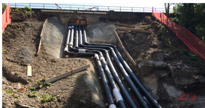
Teilabschnitt Torfeld Telli: 2 Stahl- und 3 PE-Leitungen.
