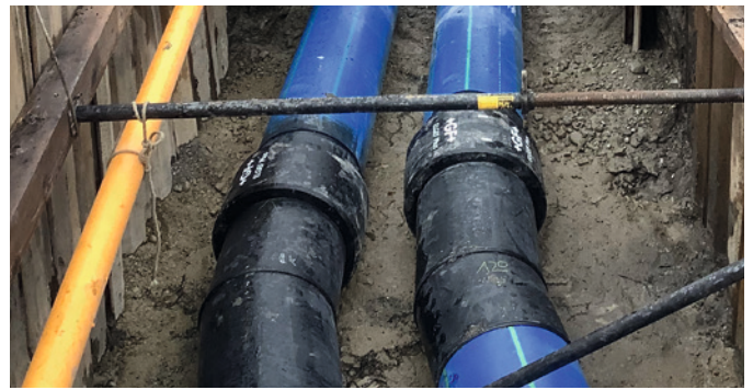
Problemlos und wirtschaftlich: Fixpunktanbindungen mit ELGEF Plus-Muffen.
