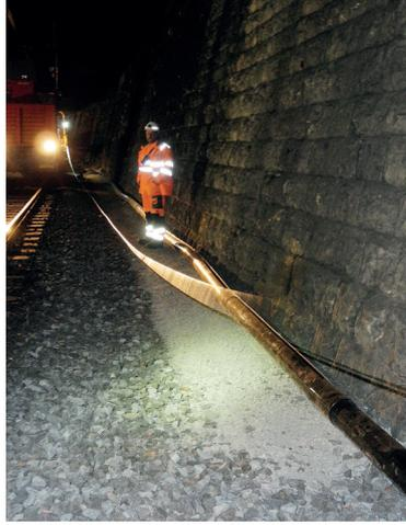
Ausrichtung der LV-Noflam-KSR, Einlegen der Kabel und Montage der LV-Noflam-Muffen (Abb. 3).
